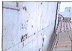
漏水調査時の様子 自由の会より漏水の状況で侵入し、 換気口付近、換気口付近に漏水が 発生している状態です。 漏水の状況を確認し、 漏水の箇所を特定 する必要があります。
